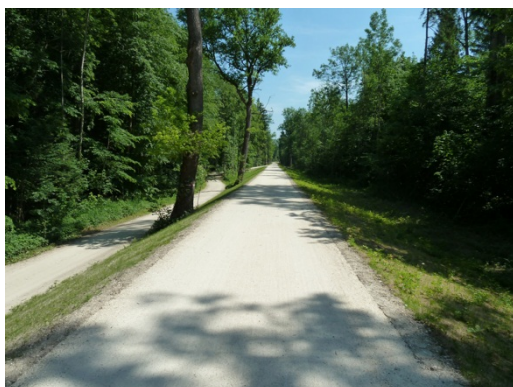
Neuer Deichabschnitt mit Deichhinterweg zur Deichverteidigung im Hochwasserfall
